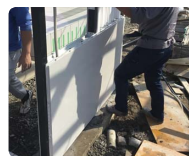
スマート・Fウォール パネル組付け
