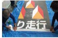
設置面を清掃後、設置位置を決め、フィルム表面端部4辺にマスキングします。
