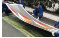
接着剤の乾燥後、施工面にフィルムを貼り合わせます。また、フィルム表面端部のマスキングを除去します。
