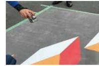
オーバーコートが硬化乾燥する前に反射ビーズを全面に均一に散布します。
