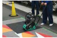
ゴムハンマーで空気を抜くよう圧着します。特にエッジ部分は十分に圧着して下さい。(コンパクターでも圧着可能です。)
