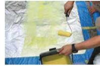
専用接着剤をフィルム裏面に均一に塗布し、指で触れても付着しなくなるまで十分に乾燥させます。(室温:約20分)
