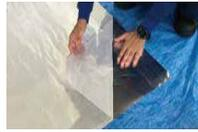
フィルム裏面のバックングテープを除去します
