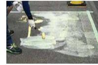
専用接着剤をマスキング内側の設置面に均一に塗布し、指で触れても付着しなくなるまで十分に乾燥させます。(室温約20分)
