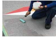
2液(主剤と硬化剤)のオーバーコートをよく混ぜ合わせた後、ローラーを用いて均一にオーバーコートを塗布します。
