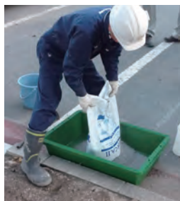
人力による練り混ぜ (使用量が少ない時)
