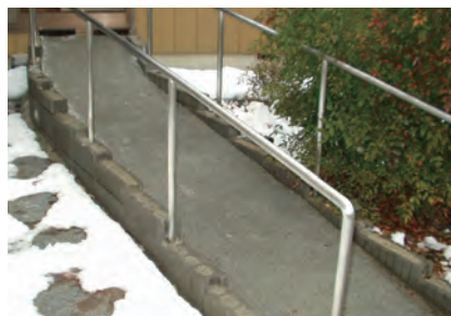
施工例 スロープ
