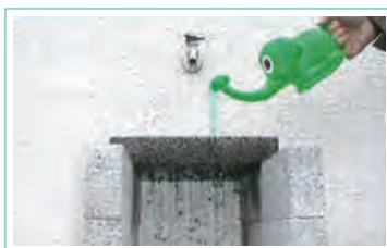
透水くんIIを使用したコンクリートの透水状態
